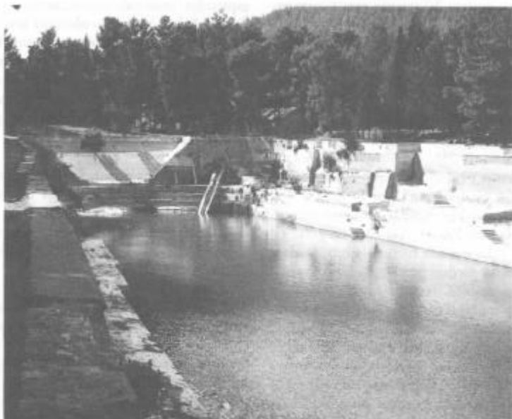
Uno de los tres estanques de Salomón, al sur de Jerusalén. Los tres estanques están en niveles separados y conectados por conductor. Eran parte de la provisión de agua para Jerusalén en la época romana. Chrirsia Seffie Ben-Yoseph
